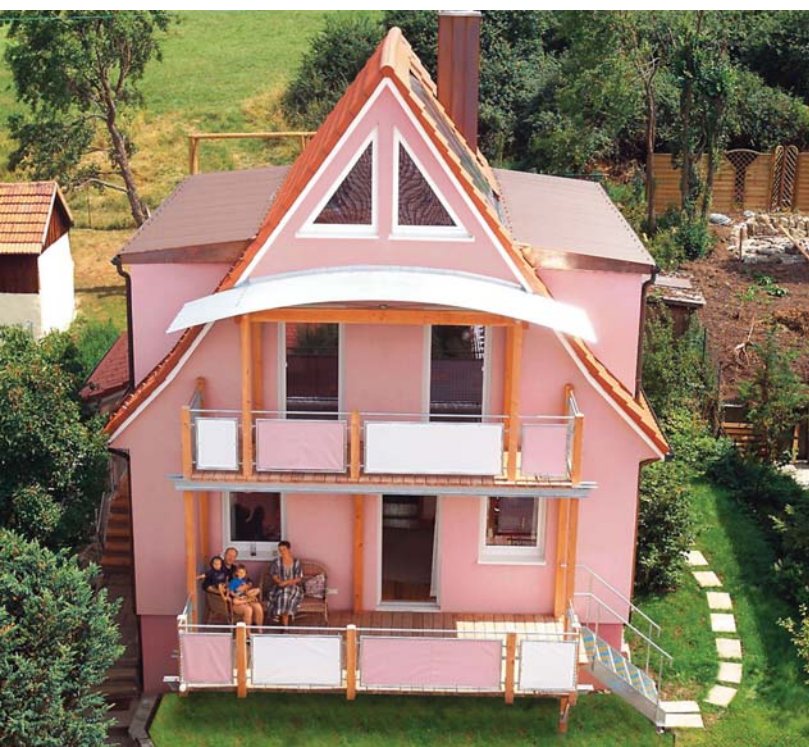
Eine Sanierung wertet ein in die Jahre gekommenes Familienheim nicht nur optisch auf, sondern verbessert auch dessen Energieeffizienz nachhaltig. Foto: djd/Sto AG
